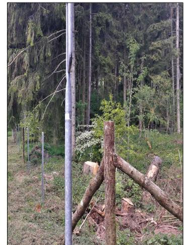
Danach können mithilfe der Rammkatze die Pfosten versenkt werden, wobei vorher zunächst ein Loch mit dem Locheisen „vorgerammt“ werden sollte. Wichtig dabei ist, dass das Loch grade aber nicht zu tief ist, denn sonst steht der Pfosten nachher krumm oder sitzt locker. Stehen die Pfosten alle in einer Flucht, können diese verstrebt werden.
